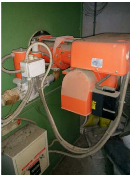
Figura 1: Generatore di aria calda e bruciatore esistenti
