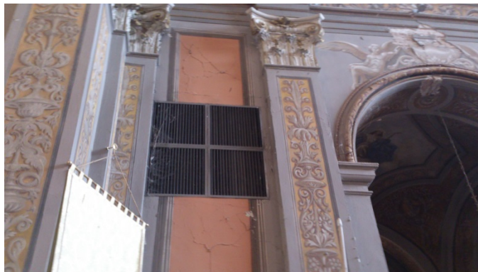
Figura 3: Griglia di mandata aria calda da mantenere
