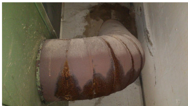
Figura 2: Canale da fumo esistente
