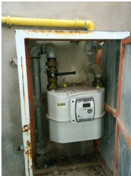
Figura 5: Misuratore gas metano esistente
