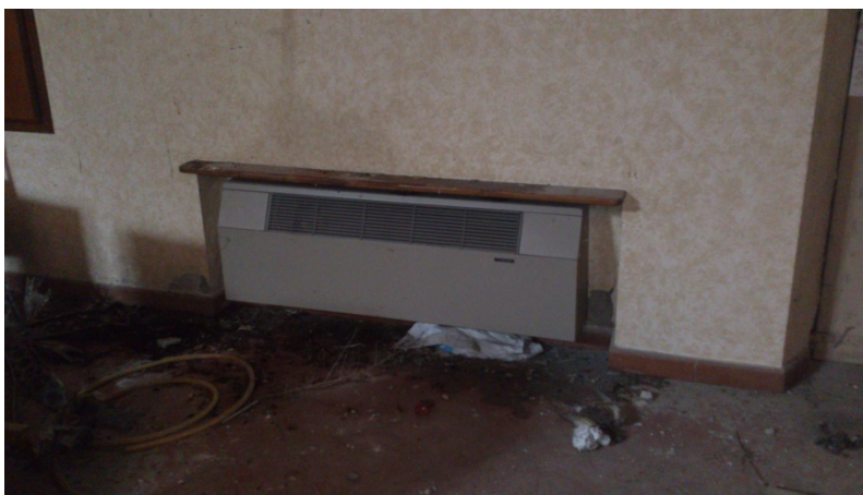
Figura 6: Ventilconvettori esistenti nella cappella
